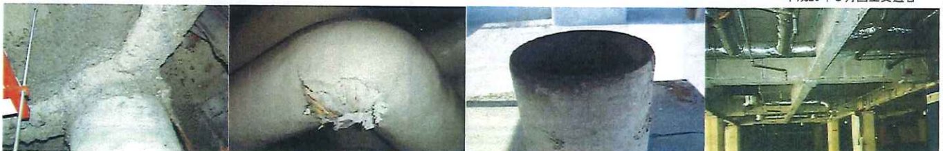
柱や梁に施工 吹付け石綿
