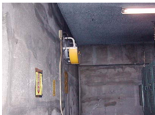
天井に吹付けRW(乾式・半乾式)、壁はモルタル
