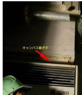
（参考資料）写真6-11 キャンバス継ぎ手
